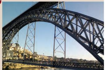
Se compone de dos plataformas unidas por un arco, que estaba considerado, en el momento de su construcción, el mayor arco de acero del mundo. En lo que respecta a su estructuración, el armazón del puente es de hierro y se asemeja a una pieza de filigrana.
