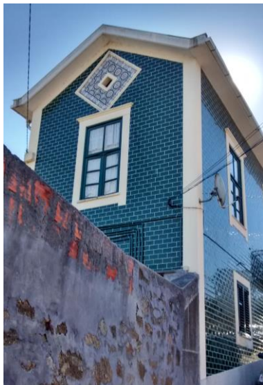
Fotografias: ano 2016. Construção reabilitada
