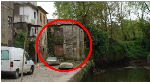
Fotografia: Lauren Maganete, ano 2010. Anterior à demolição
