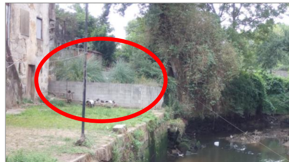
Fotografia: ano 2015. Após a demolição
