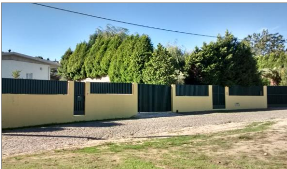
Vista das construções existentes a sul, face à Rua do Areinho
