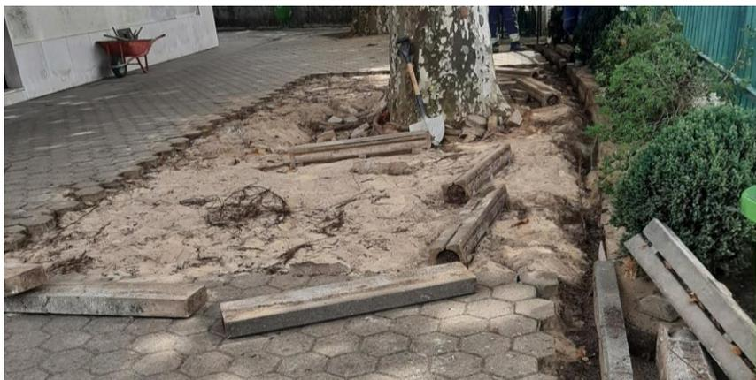
No recreio do Jardim de Infância do Alquebre, foi realizado o alargamento da caldeira de uma árvore, de forma a eliminar os desníveis verificados no pavimento envolvente, provocado pelas raízes da mesma.
