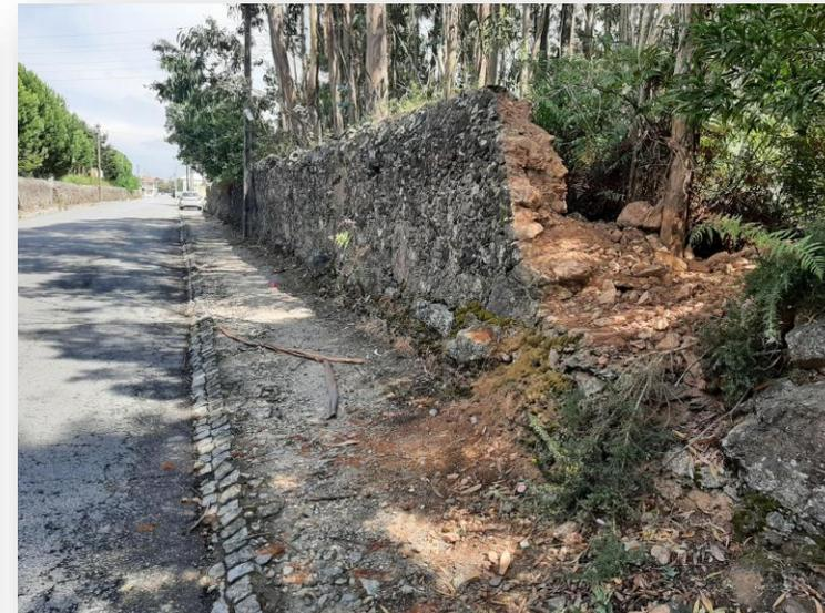
Durante o mês de setembro fomos chamados a intervir no âmbito da Proteção Civil na Rua Póvoa de Cima, em Grijó, no sentido de procedermos à remoção de pedras caídas na via pública e à demolição parcial de um muro de vedação em risco de desmoronamento.
